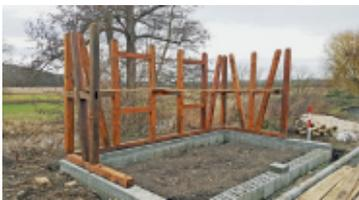
Fachwerk zu errichten. Alle Balken haben wir im Dezember noch zweifach mit Holzschutzfarbe lasiert, so dass einem Einbau nichts entgegen stand. Die Bilder vermitteln einen kleinen Eindruck
