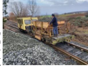
Nach einigen Versuchen haben wir schnell die beste Methode gefunden, die Schwellen und das Gleis zu installieren. Nach dem Einschottern musste das Gleis noch gerichtet und gestopft werden, damit die Gleislage in einem ordentlich befahrbaren Zustand ist. Das könnte man natürlich per Hand erledigen... Der Arbeitsaufwand wäre aber sehr groß. Und das Ergebnis nicht wirklich perfekt.
