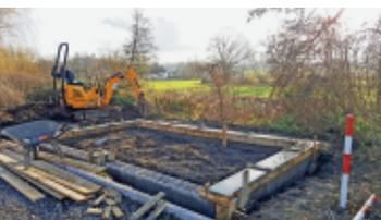
Und es kam Hilfe: Tobias Hummel meldete sich und bot an, das Fundament in Form eines Ringankers zu errichten. Mit Tatkraft und Unter-
